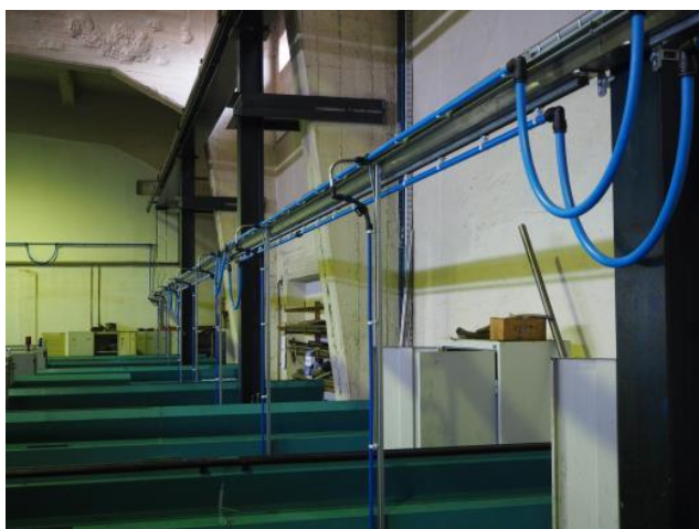
Abbildung 3: Der Kühlschmierstoff wird über die blauen Kunststoffschläuche zu den Maschinen verbracht.
