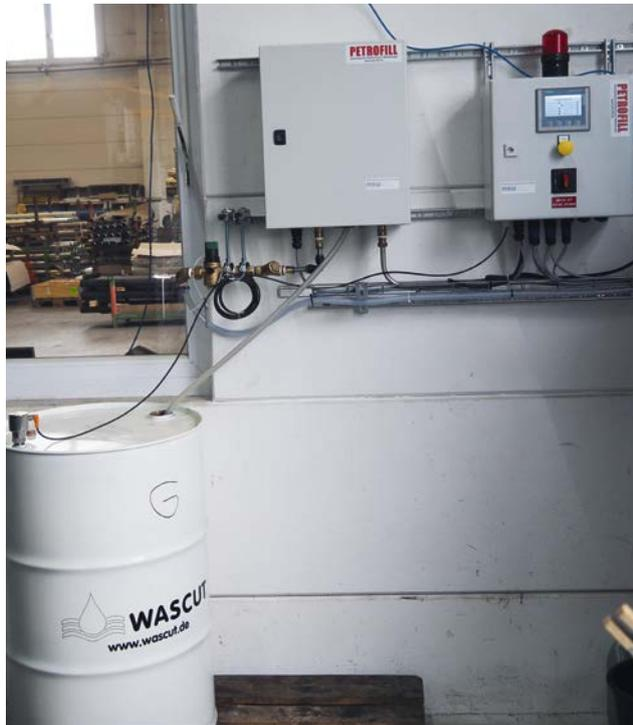
**2** Wenig Platzbedarf und eine einfache Installation zeichnen die PetroFill-Anlage aus. Das Konzentrat wird direkt aus dem bereitgestellten Fass gezogen und angemischt sowie über Schläuche zu den Werkzeugmaschinen transportiert
