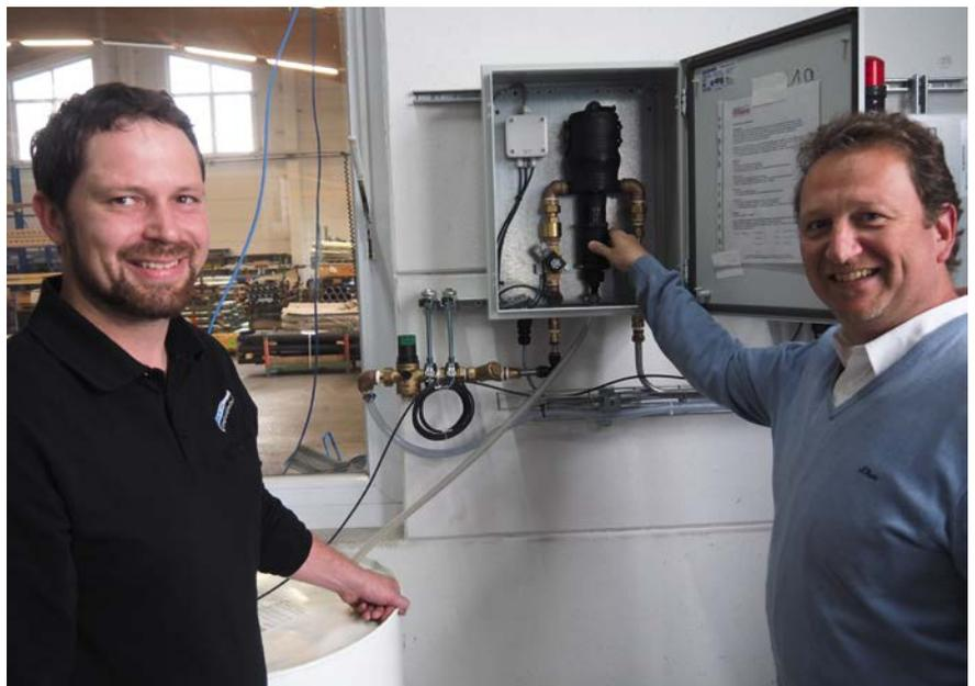
**1** Fertigungsbeauftragter Josef Helmer (links) ist mit der Entlastung, die ihm die Petro-Fill-Befüllungsanlage bietet, sehr zufrieden. MAW-Vertriebsingenieur Wolfgang Heckl zeigt die verbaute Mischereinheit, an der die Konzentration eingestellt wird (© Hanser)
